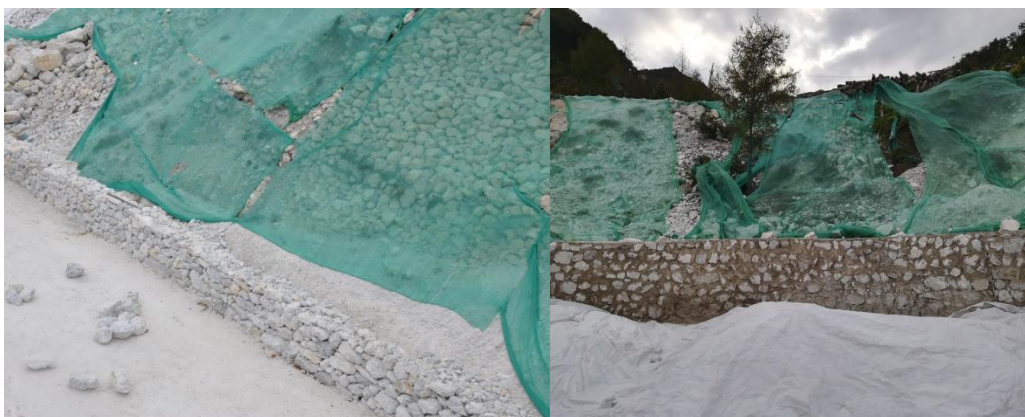
废岩场防治区挡渣墙
