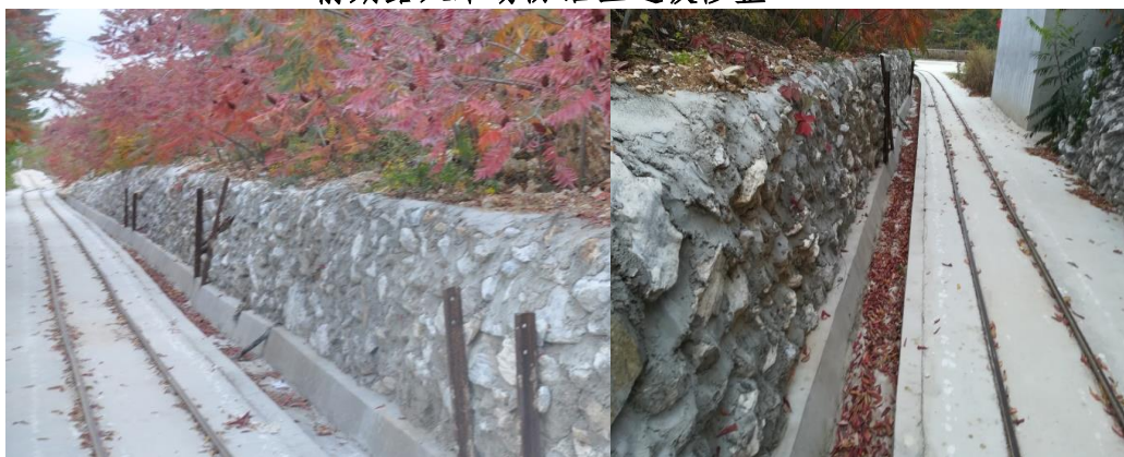
工业场地防治区挡土墙及排水沟
