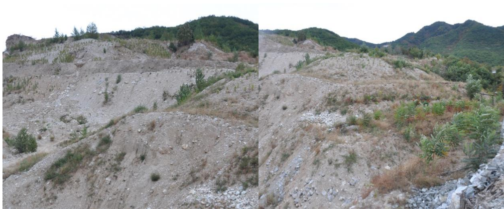
前期露天采场防治区边坡修整
