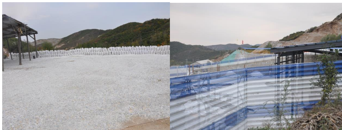
临时拦挡措施及防风抑尘网
