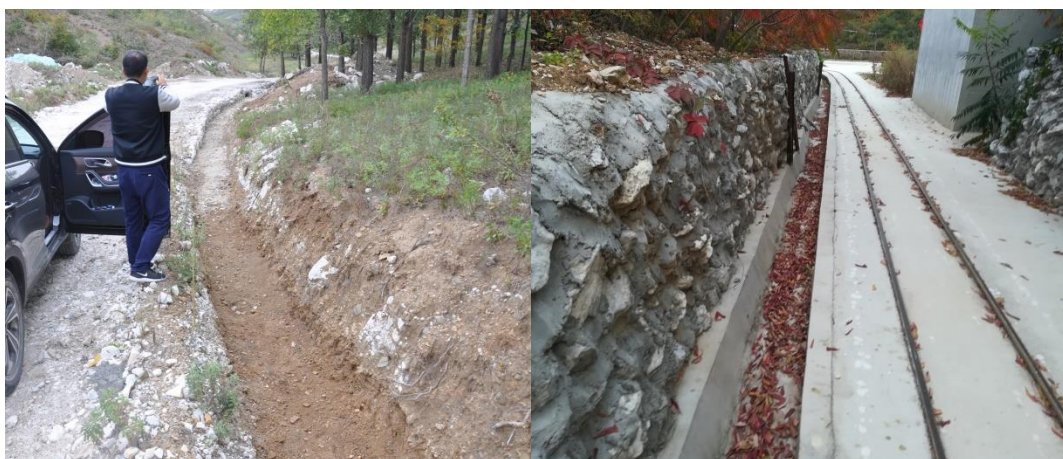
排水沟长度测量（2018. 9. 12）
